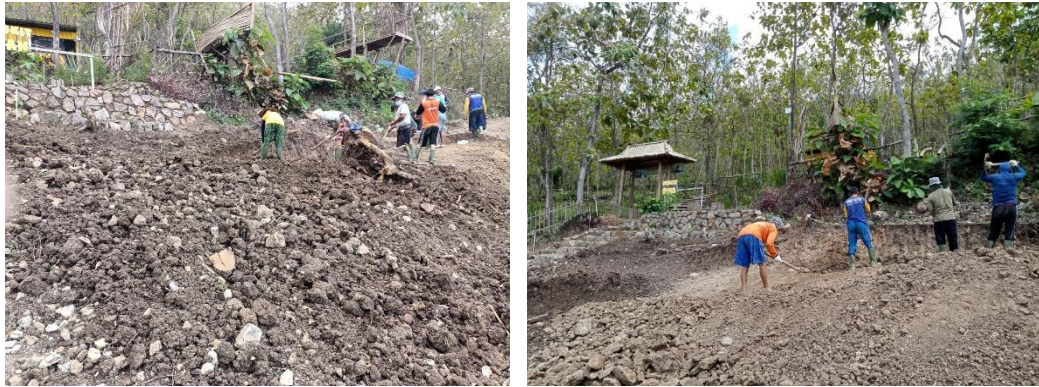
Gambar 3. Pendampingan pembuatan rute jalan dengan teknik macadam
