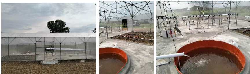
Gambar 5. Konstruksi bangunan greenhouse
